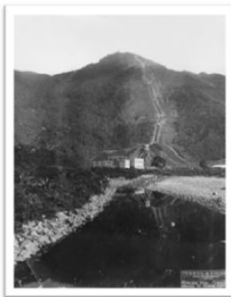
Vista geral da Usina de Cubatão. 22/12/1927. Notação: ELE.CEI.SDM.013.011. Acervo Fundação Energia e Saneamento
