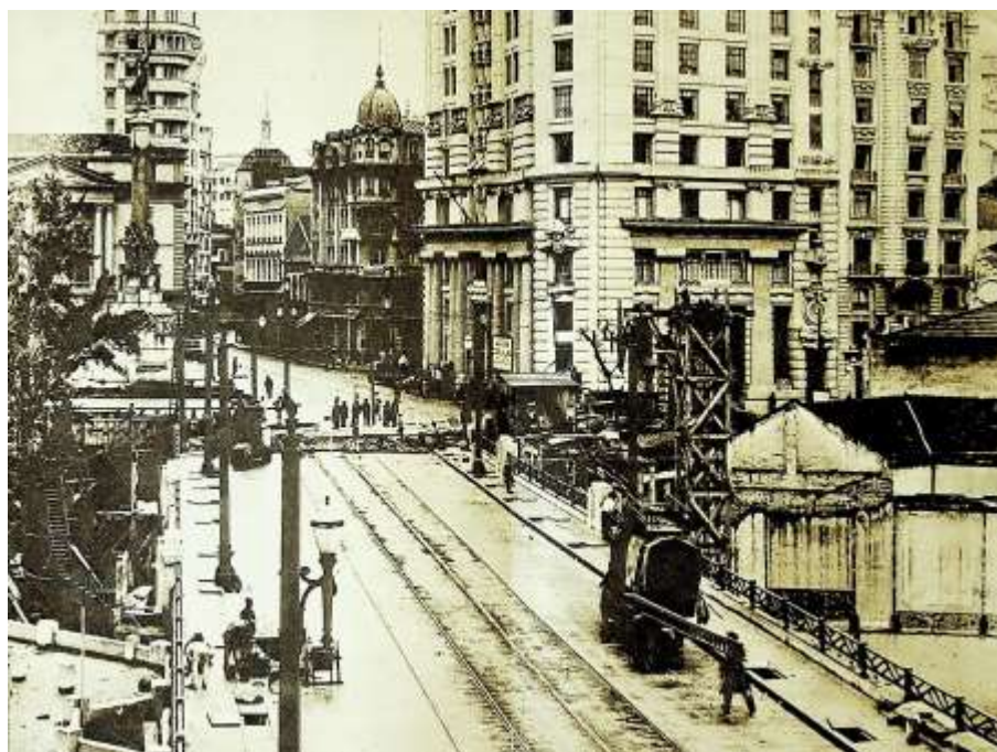
Fotografia da construção do Viaduto da Boa Vista em São Paulo, de 1932 (ELE.RPU.MPI.0128.048) Fonte: Acervo Fundação Energia e Saneamento
